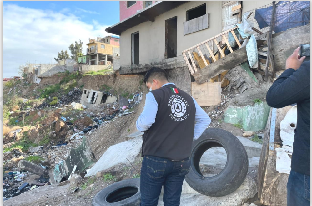
ZONA DE DESLIZAMIENTO. Se ha utilizado como tiradero de basura y escombro.
