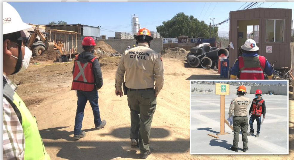
INSPECCIÓN DE CONFORMIDAD. Para revisión de medidas de seguridad en obra de almacenes.
