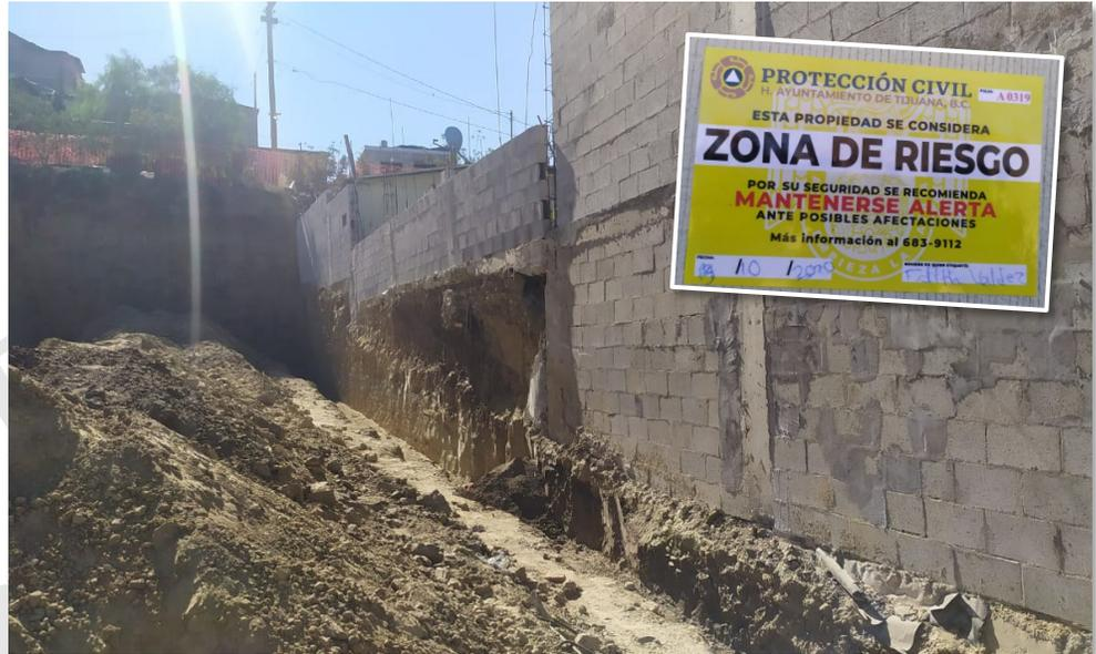
**TALUD CON GRADO RECTO DE INCLINACION.** Cortes y excavaciones exponen cimentación de barda perimetral de predio colindante.
