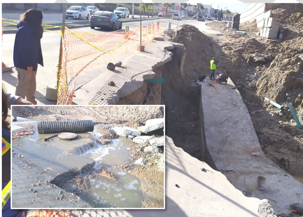
VERIFICANDO CONDICIONES. Remoción de losa de rodamiento a un costado de puente.
