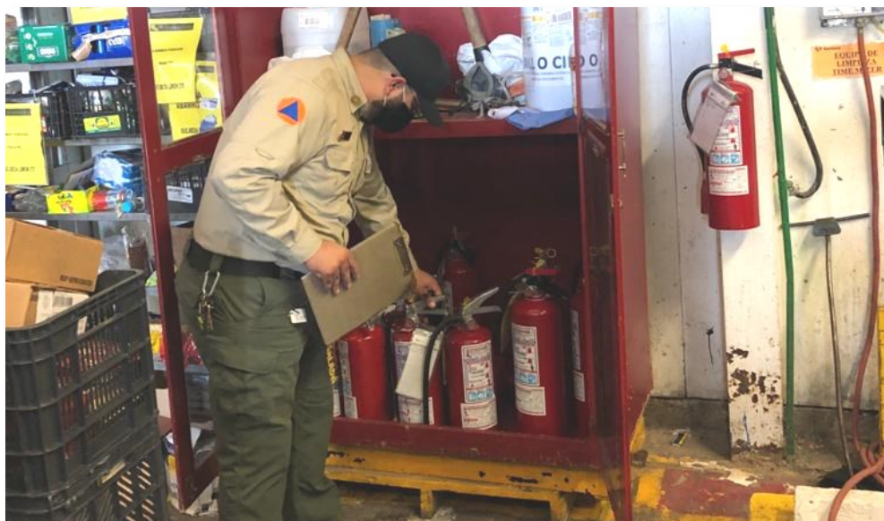
VERIFICACIÓN. De equipo de extintores en tienda de autoservicio.
