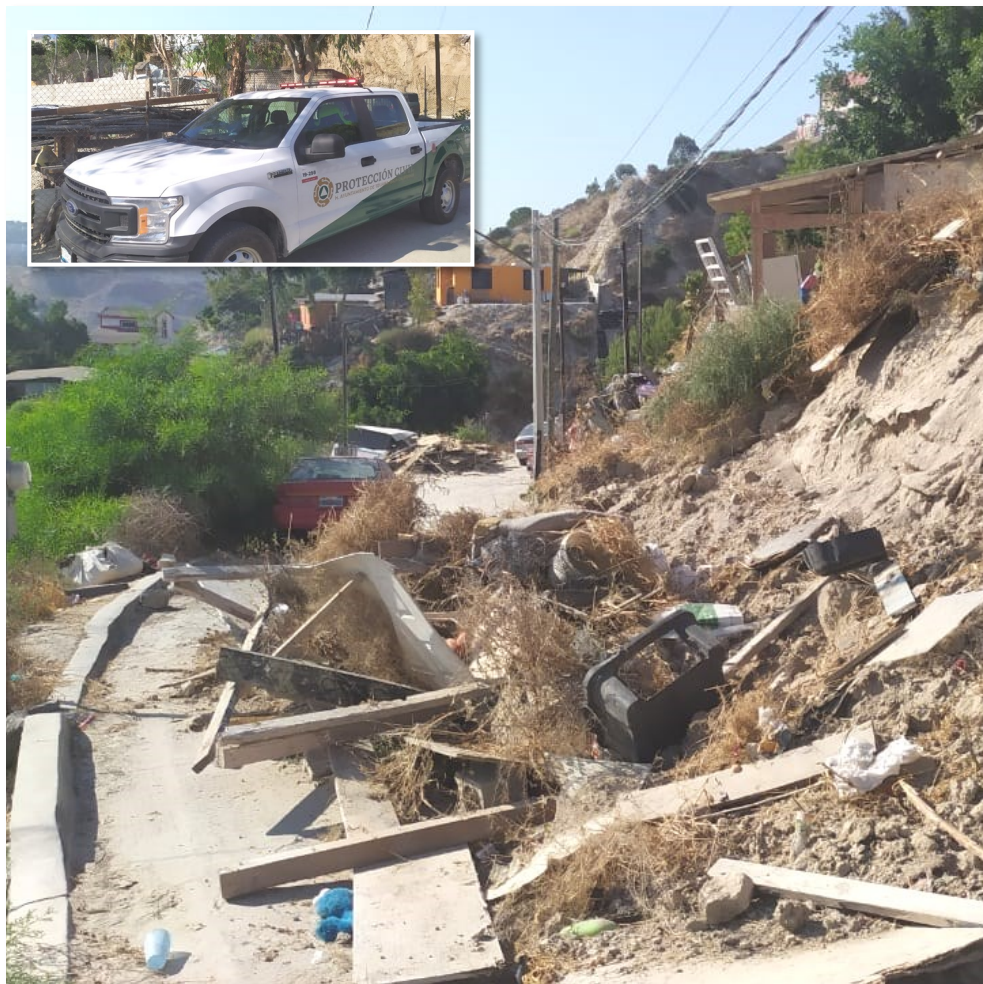
VIALIDAD BLOQUEADA: Escombros y material quedaron sobre vialidad.
