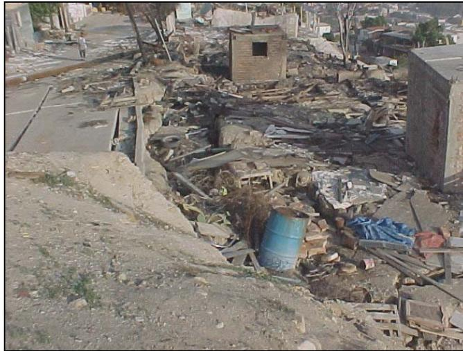
Figura 3. Colonia Defensores de Baja California. Presencia de una falla e intenso fracturamiento, combinado con cortes inadecuados de terreno, intemperismo químico, introducción de aguas residuales y por ruptura de tuberías. Las personas afectadas alcanzaron un número aproximado de 60 familias.
