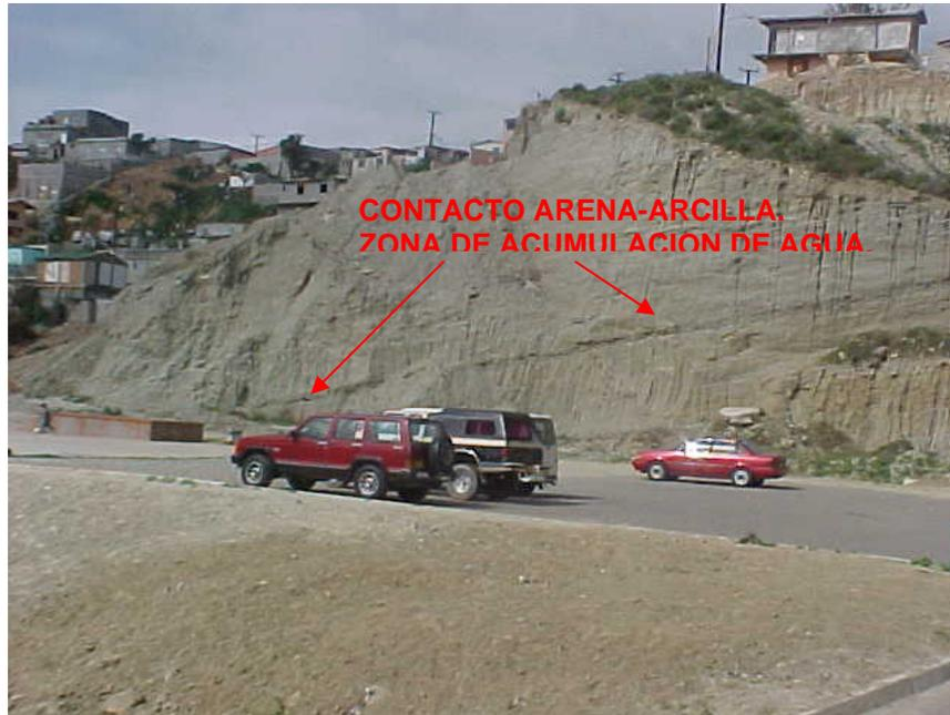
Figura 11. Se muestra la zona de contacto entre arenas-arcillas. El efecto impermeable de arcillas no deja circular el agua formandose una pelicula de agua y un potencial alto de deslizamiento de la masa de arenas en la direccion del plano inclinado del estrato.
