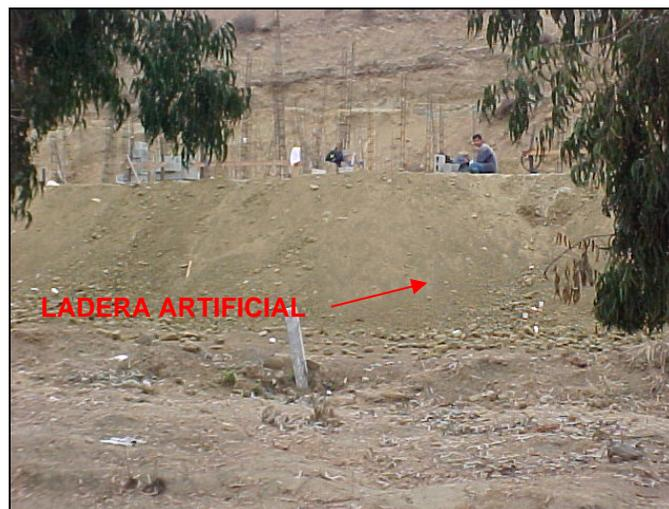
Figura 6. Ladera artificial creada por movimientos de terreno y formación de terraplén.
