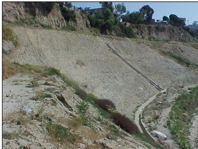
Figura 18. Construcción de bermas para conducción de agua superficial.
