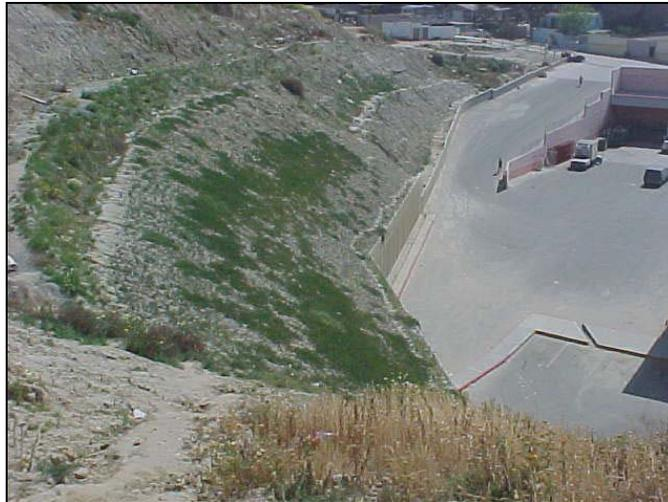
Figura 19. Muro de contención y sembrado de vegetación para evitar infiltración de agua.
