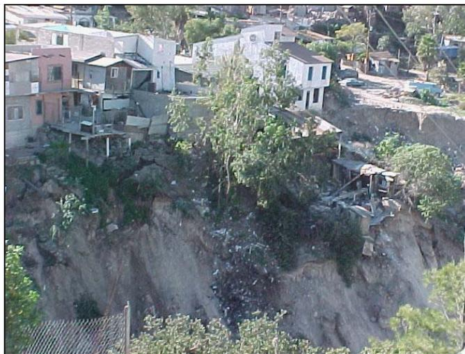
Figura 4. Colonia Anexa Ramírez-Cumbres del Rubí. Presencia de 4 fallas, intenso fracturamiento, intemperismo químico, cortes inadecuados, introducción de aguas residuales, pesos excesivos, entre otros, afectó aproximadamente 80 familias.
