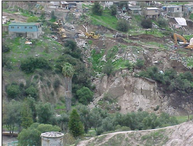
Figura 2. Colonia Los Maestros. Afectación de aproximadamente 10 viviendas y ruptura de un tramo de acueducto Aguaje de la Tuna.
