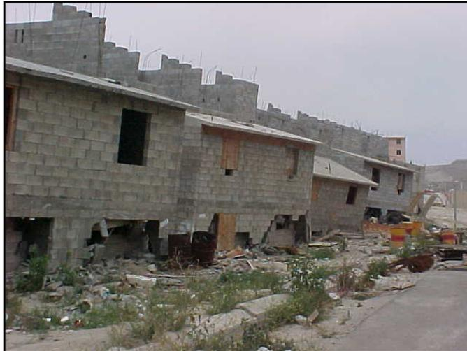
Figura 1. Colonia Lomas del Río, parte baja. Afectación de 18 viviendas en construcción y 6 edificios de 6 niveles c/u. Afectaciones al terreno (cortes inadecuados, introducción de agua, combinación de estratos de arenas-arcillas) en varios puntos de la ladera superior provocaron un movimiento de ladera de magnitud considerable.
